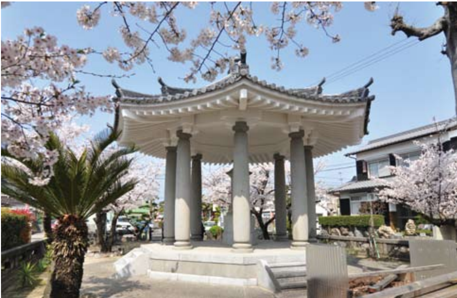
鍵谷カナ頌功堂 | 松山で製造される伊予緋は、江戸時代後期に鍵谷カナが独自に生み出した。その遺徳を偲び建てられた頌功堂に頑丈な鉄筋コンクリート造が採用されたのは、カナの功績を永く伝える意図があったともされる。[編]
